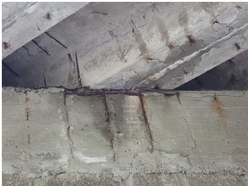
Obnažené korodující třmínky úložného prahu vpravo – pod 3. nosníkem od konce NK
