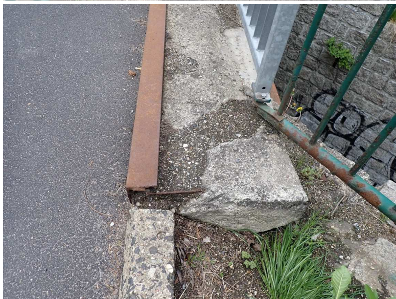
Degradace betonu 2. římsy + koroze ochranného ocel. úhelníku + koroze zábradlí na 2. křídle vpravo
