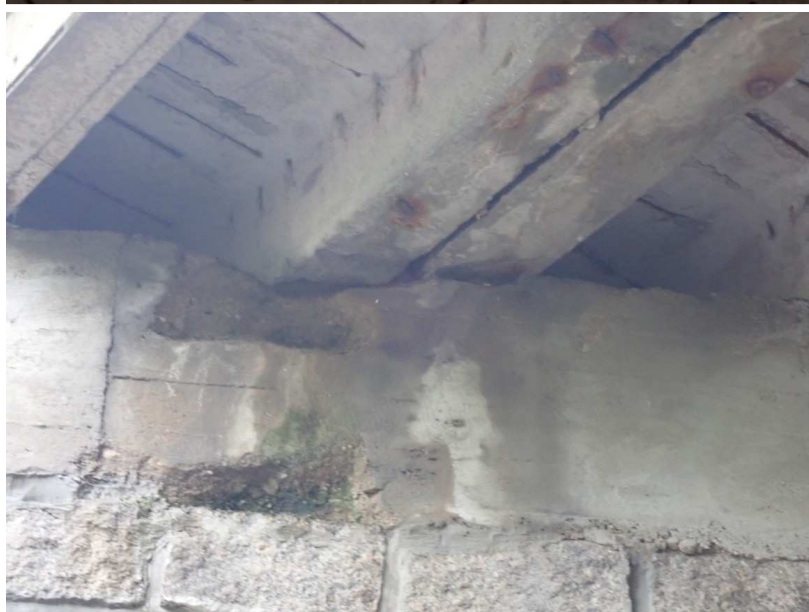
Silné zatékání spárou mezi 1.a 2. nosníkem na 1. opěru vlevo a následně degradace betonu úložného prahu
