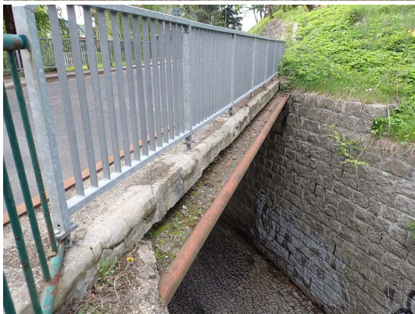
Pohled na 2. římsu a chráničky po kryté nečistotami
