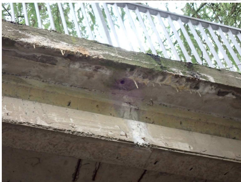
Detail pohledu 1.římsy – silně zatéká (krápníky)
