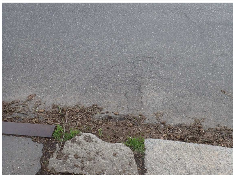
Síť trhlin v živičném krytu vozovky na konci 1. římsy vpravo
