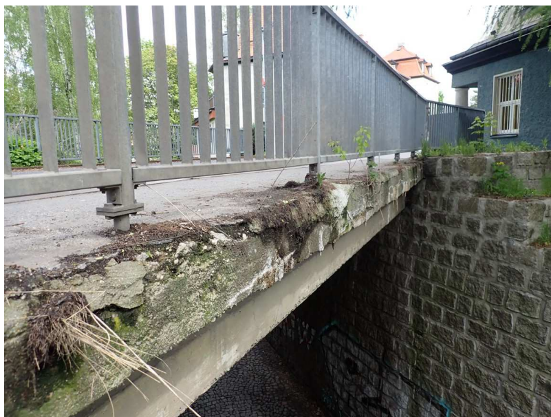
Pohled na 1. římsu – stopy po zatékání – protékající trhliny + vápenné výluhy + krápníky + počínající degradace betonu a sanace
