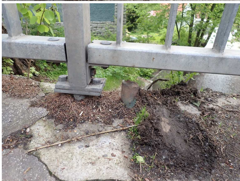
Nečistoty na 1. římse + zbytek zábradelního sloupku ponechaný v 1. římse
